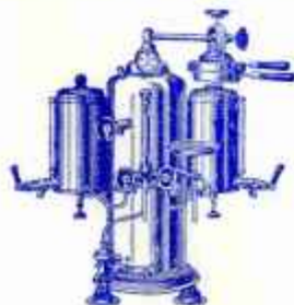
Machine à café express type 9938 II Contenance 5 litres se vend sans réservoir, avec 1 ou 2 réservoirs. Rendement 70 tasses à l'heure
